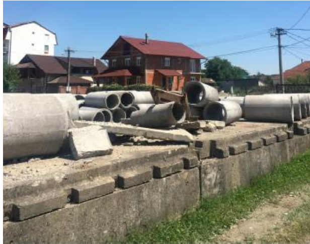
Слика 2.2.3. Бесправно саграђени темељи објекта „Б“
